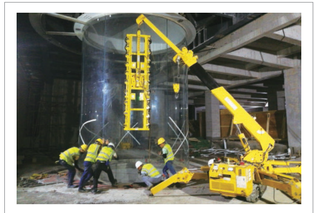
弯弧玻璃手动翻转旋转搬运 直流二十爪吸吊设备 HP-GA1000-20S (1000KG)
