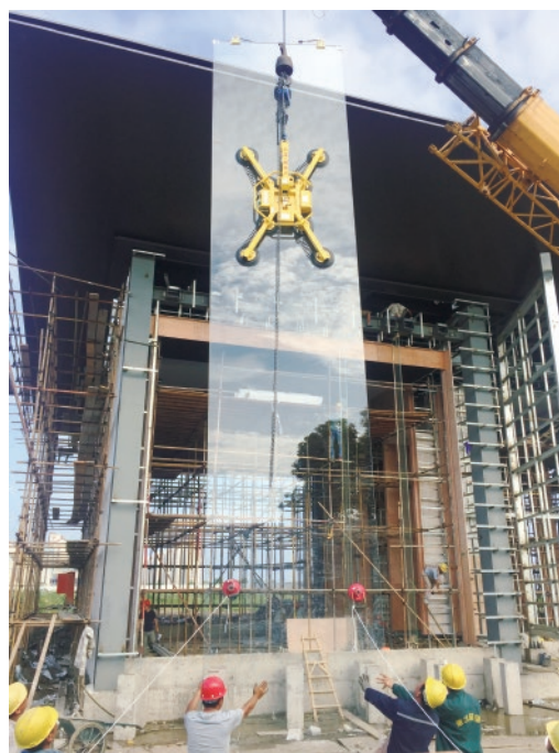
永旺梦乐城玻璃幕墙安装 直流八爪吸吊设备 HP-GX600-8S (600KG)
