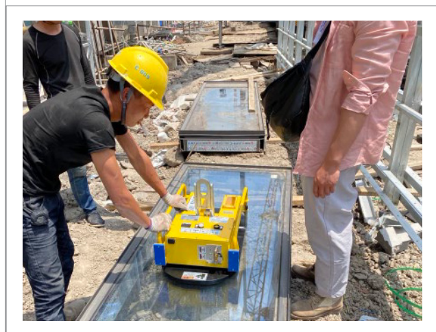
室外单元板块幕墙安装 直流单爪吸吊设备 HP-GI500-1S (500KG)
