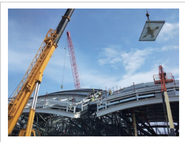
香港鉅城工程有限公司-工程应用
