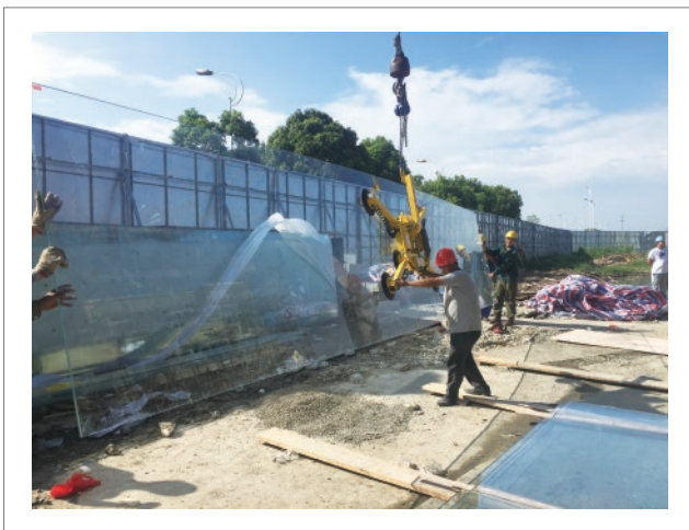
室外玻璃幕墙安装 直流八爪吸吊设备 HP-GX600-8S (600KG)
