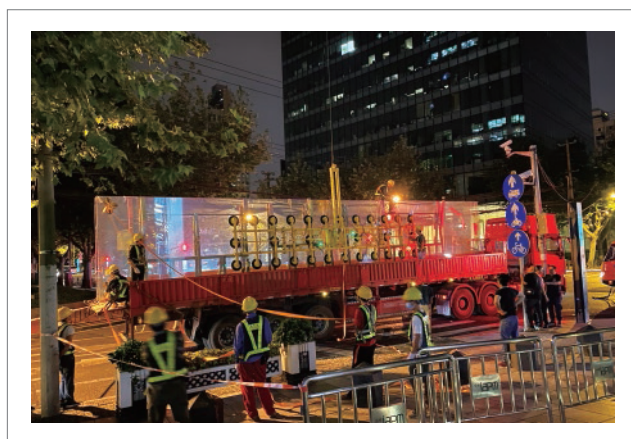
淮海路古驰店幕墙安装(双系统) 直流三十爪吸吊设备 HP-GH3000-30S (3000KG)
