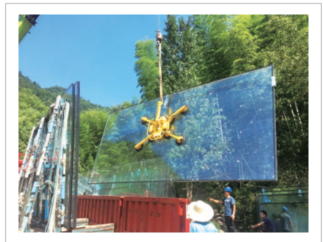
莫干山名宿玻璃幕墙安装 直流八爪吸吊设备 HP-GX600-8S (600KG)
