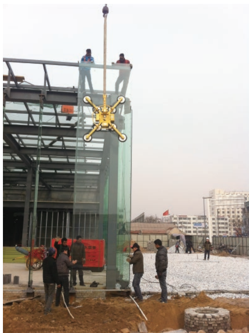
时代广场玻璃幕墙安装 直流八爪吸吊设备 HP-GX600-8S (600KG)
