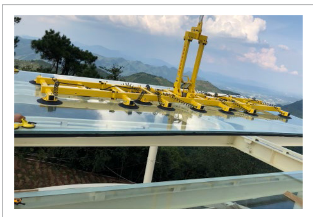
天空之城玻璃栈道安装 直流二十爪吸吊设备 HP-GH2000-20S (2000KG)
