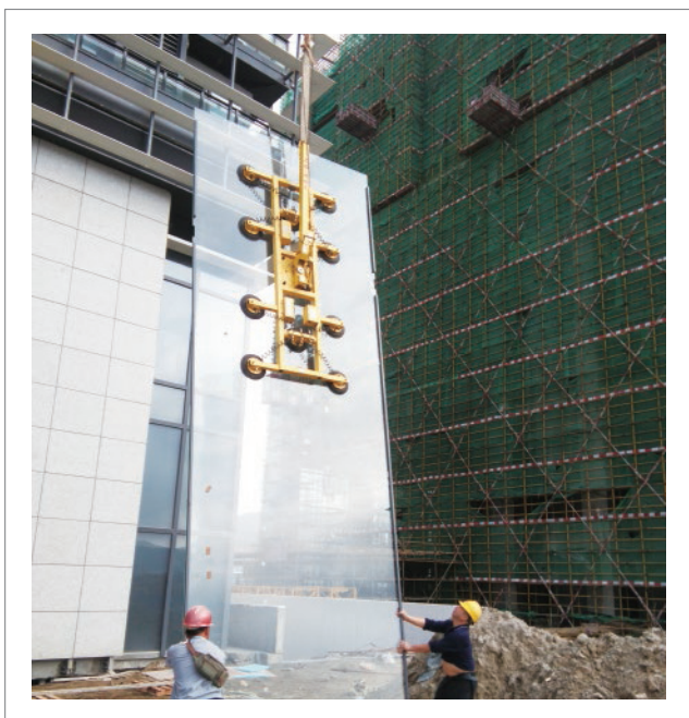
杭州银泰购物中心幕墙安装 直流十爪吸吊设备 HP-GH1000-10S (1000KG)
