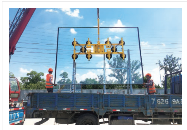
博世中国厂房幕墙安装 直流十爪吸吊设备 HP-GH1000-10S (1000KG)
